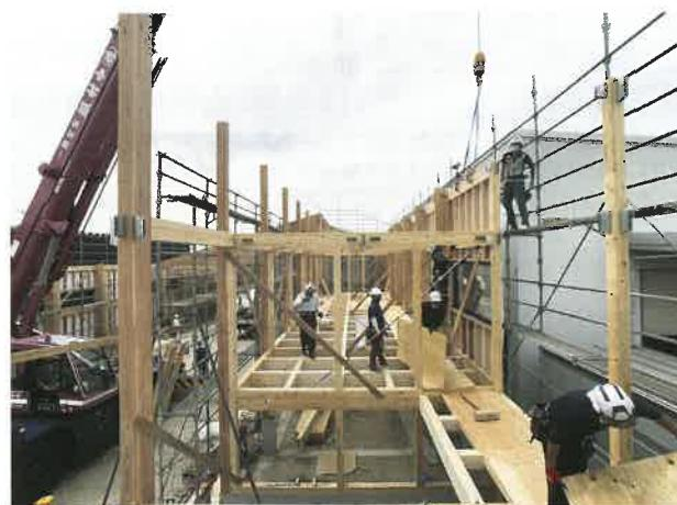
(写真5)大型パネル建て込みは3日で完了
