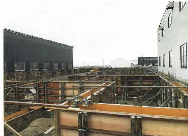
(写真4)大型パネルは基礎の精度が不可欠
