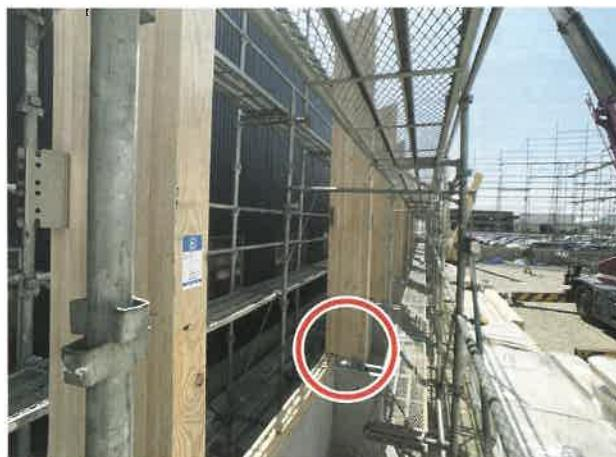
(写真3)柱脚金物で狭小耐力壁を実現する
